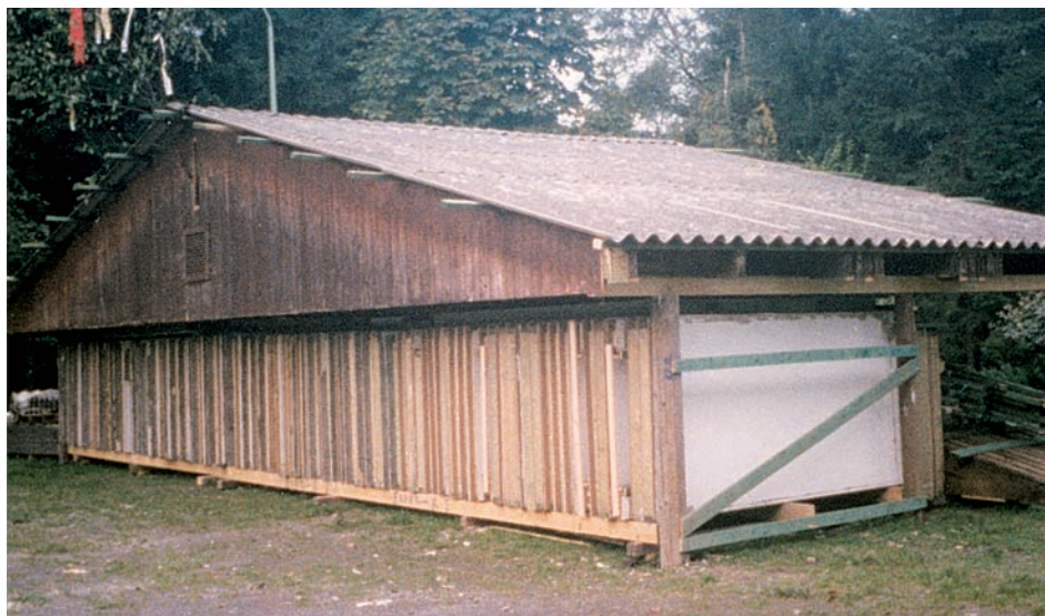
Lagerung der abgebauten Halle auf dem Festplatz in Buschhausen.
