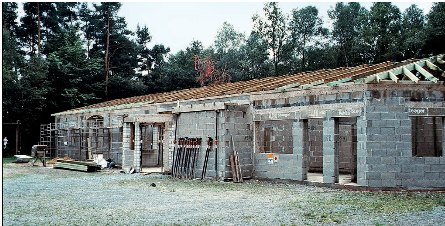
Der Richtbaum auf dem Rohbau.
