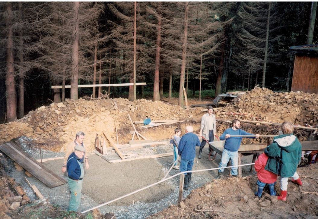
Fundamente für das Toilettengebäude: V. l. Joachim Stamm, Kurt Kleinjung, Arne Gries, Rolf Göckel, Bernhard Lusa, Klaus Noß.
