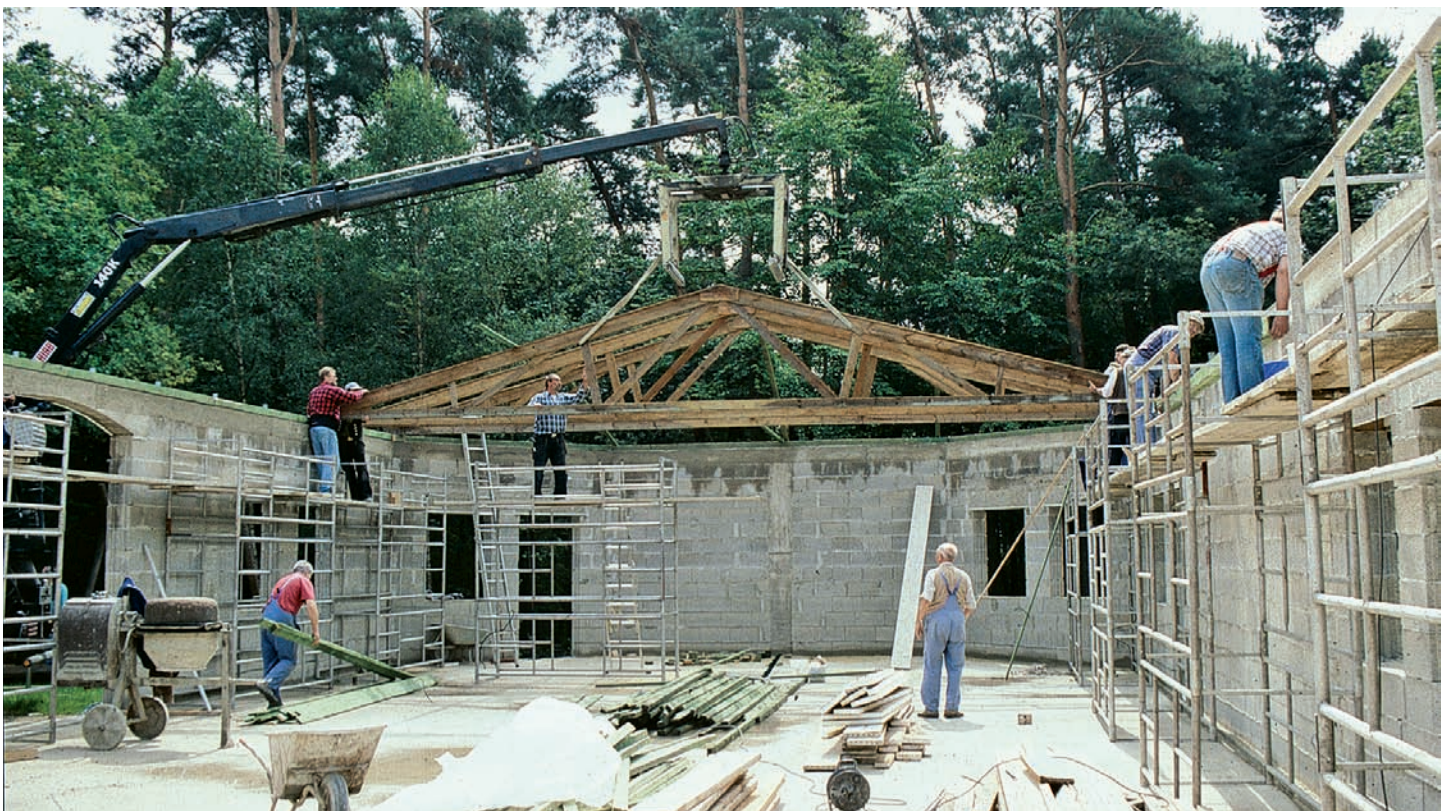
Einbau der Dachbinder, beteiligt v. l. Horst Karsubke, Klaus Noß, Uwe Drebelhof, Frank Bosch, Fritz Noß; auf dem rechten Gerüst Detlef Lusa, Helmut Wiefel, Helmut Fuchs, Achim Giesow.
