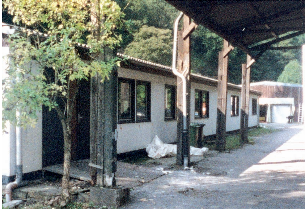
Abbau der Halle in Osberghausen.
